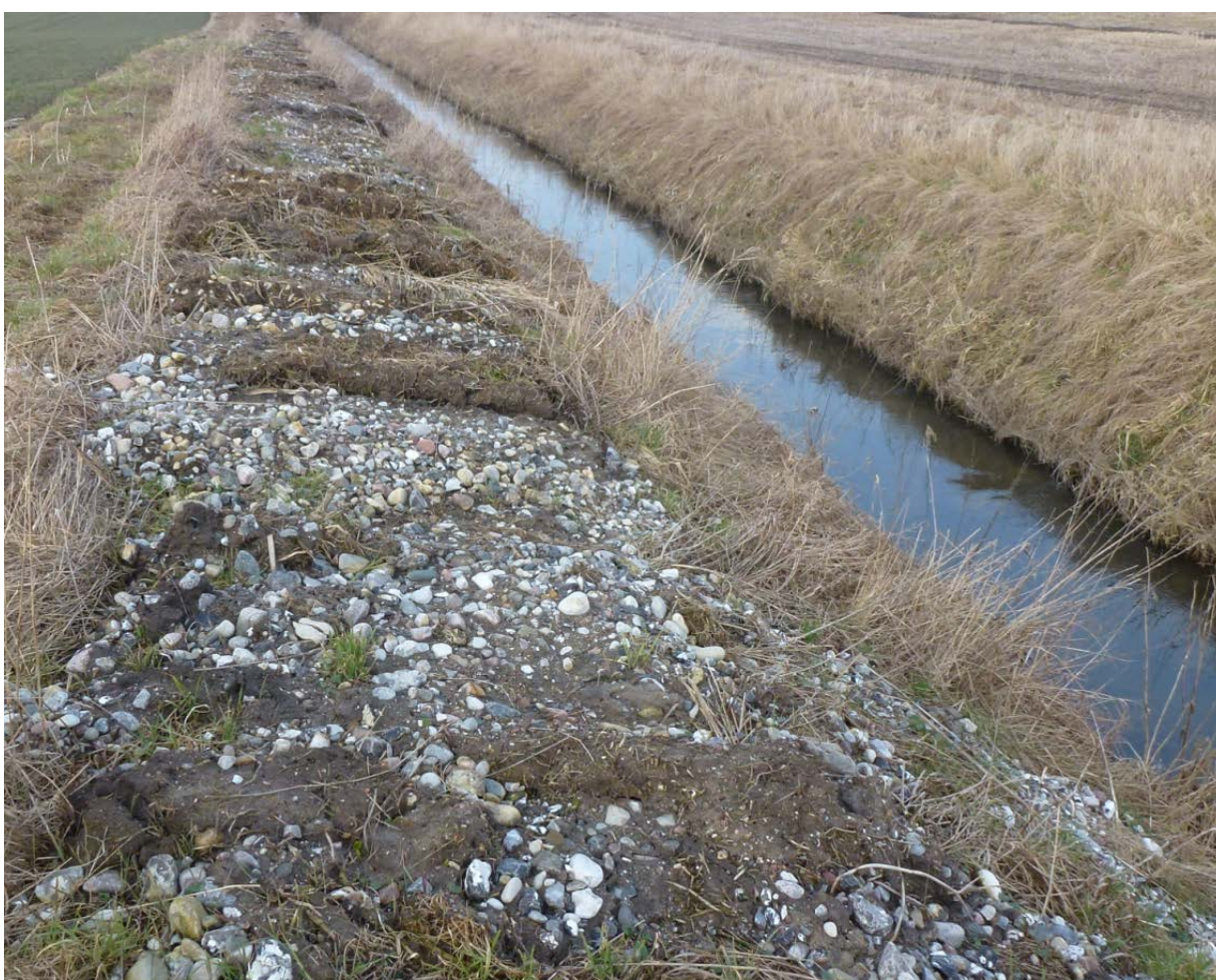
Vandløbet naturlige snoede løb i bunden af vandløbsprofilet er fuldstændigt udrettet og al variation er fjernet. Al gydebund der er udlagt for at imødekomme den biologiske målsætning, er systematisk opgravet
