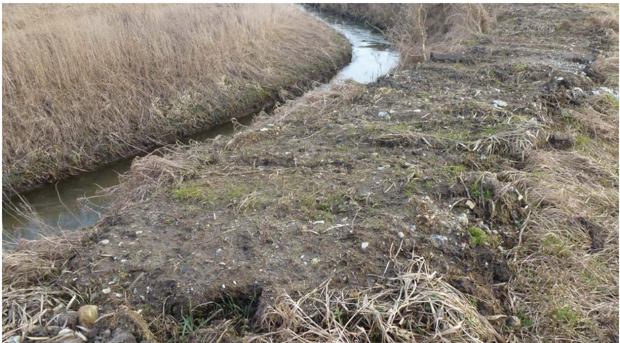
Gravearbejdet har været særdeles omfattende og har udvidet profilet langt over det regulativmæssige profil og indbefatter hovedparten af de overhængende brinkfodder, der danner naturligt skjul for laksefisen.
